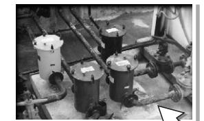
Установка фильтров серии L: на напорной и всасывающей магистралях
